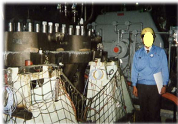
設計したプラント機械の性能試験
