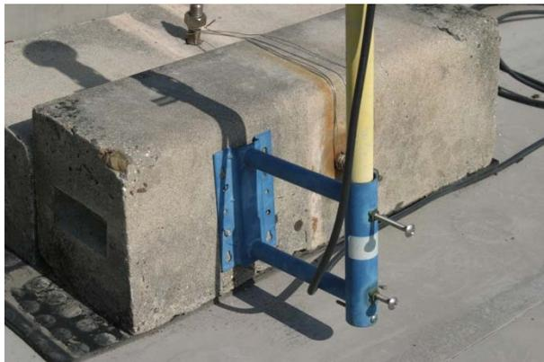
図9 GPS アンテナ 取り付け部
