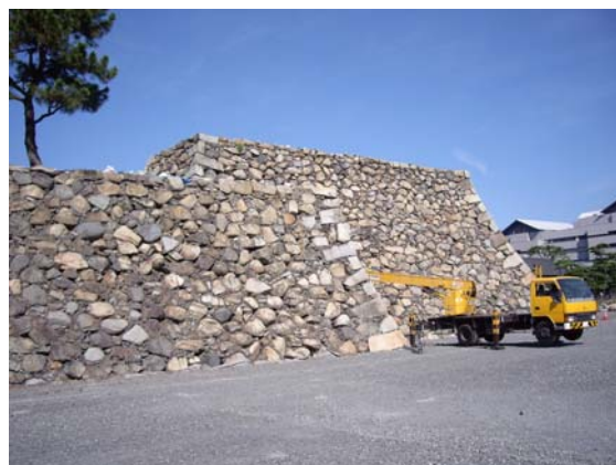
写真-1 高松城改修工事現場
