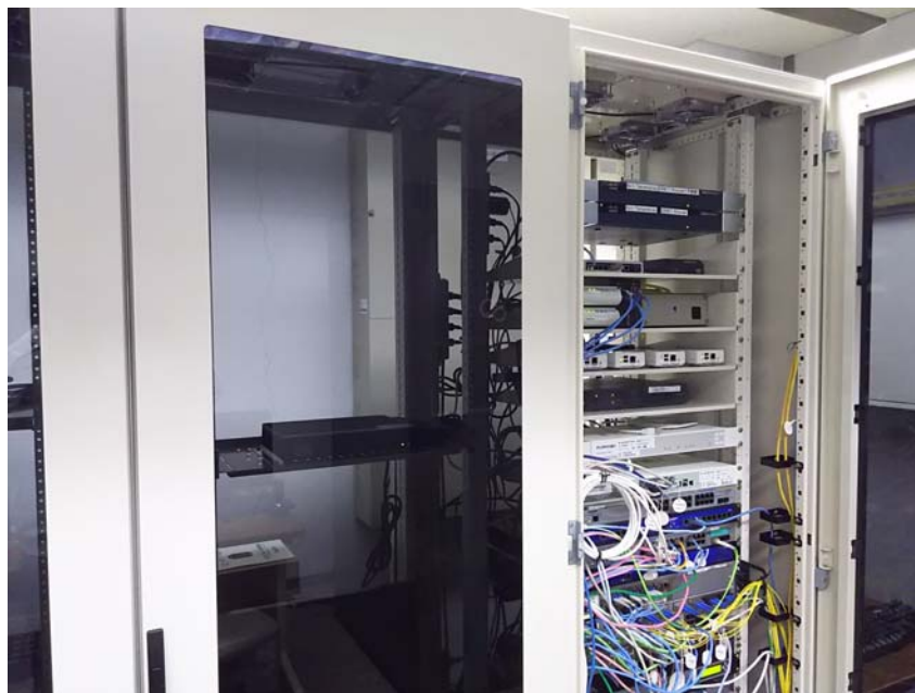
図1 ネットワーク設備
