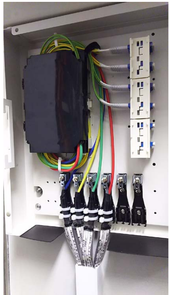
図1 光成端箱内部
