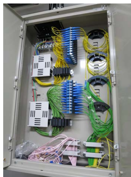
図2 第1学科棟へ新規に設置した光成端箱
