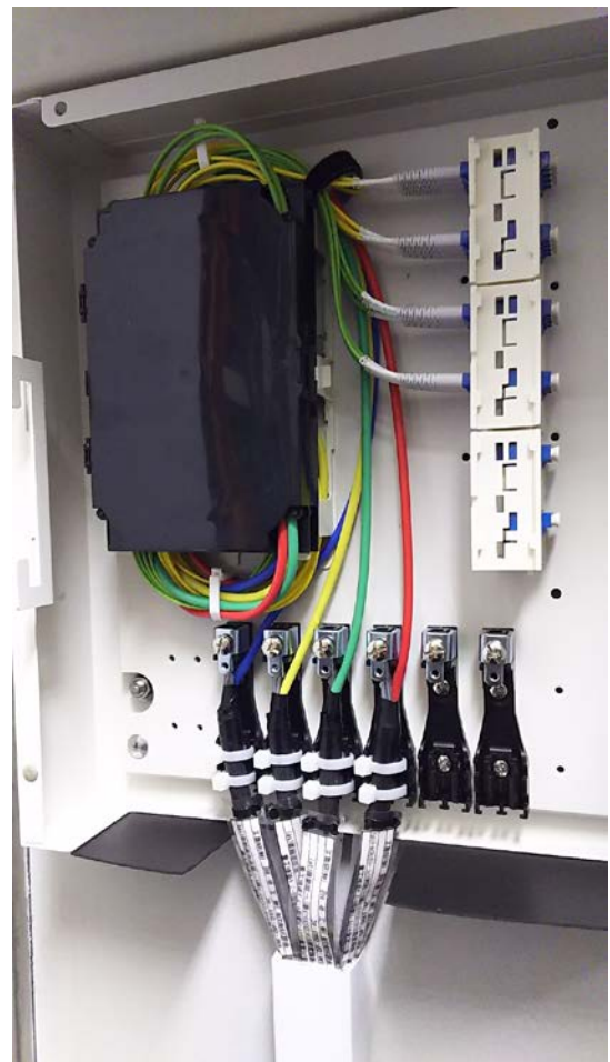
図1 光成端箱内部
