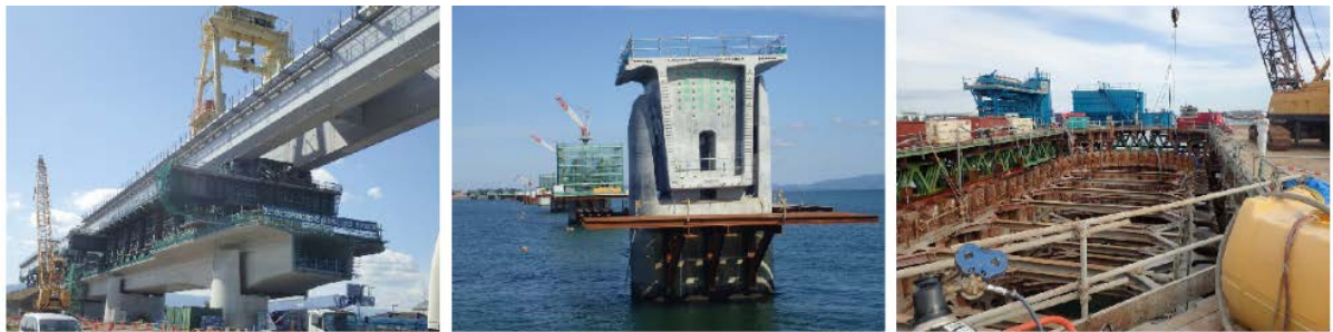
吉野川・新町川河口にかかる橋梁の建設現場の様子
