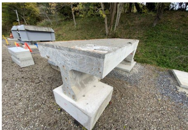
麦野跨線橋(プレストレストコンクリート桁)
