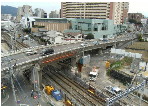
図-5 麦野跨線橋供用時
