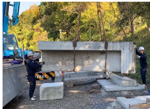
図-6 麦野跨線橋設置状況
