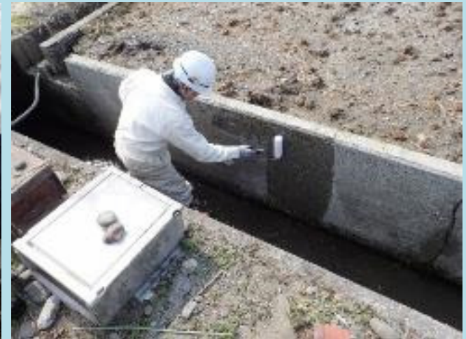
コンクリート水路の補修
