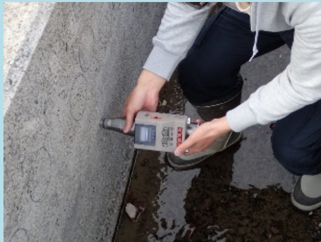
コンクリート水路の現場調査
