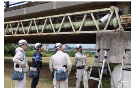
実橋梁での点検講習
