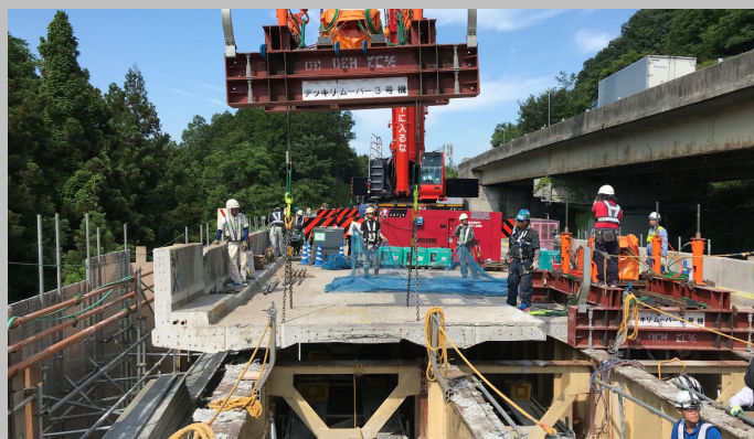
既設RC床版撤去状況（イメージ）
