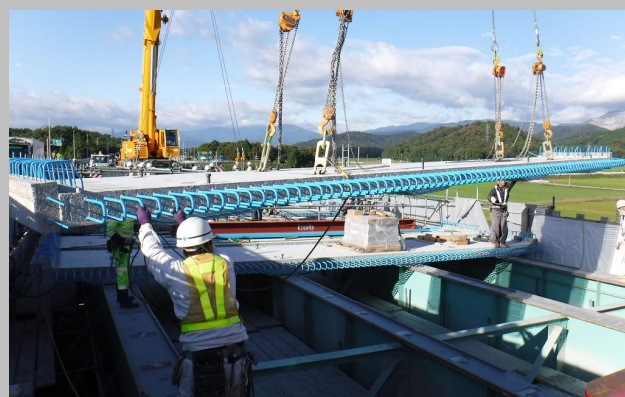
プレキャストPC床版架設状況（イメージ）
