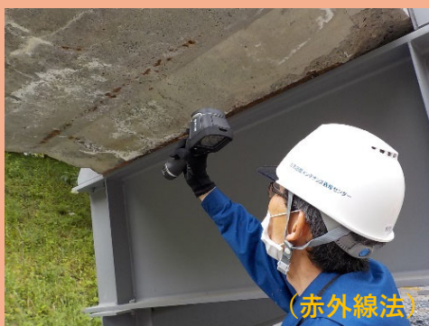
非破壊検査状況 (電磁波レーダ法)
