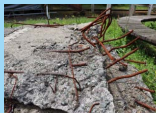
床版の使用鉄筋：丸鋼
