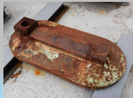
写真 八幡橋 線支承（下沓のみ）
