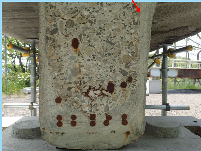
断面修復による補修跡
