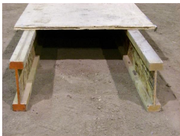
写真6 棒高跳び助走路 (接続部)
