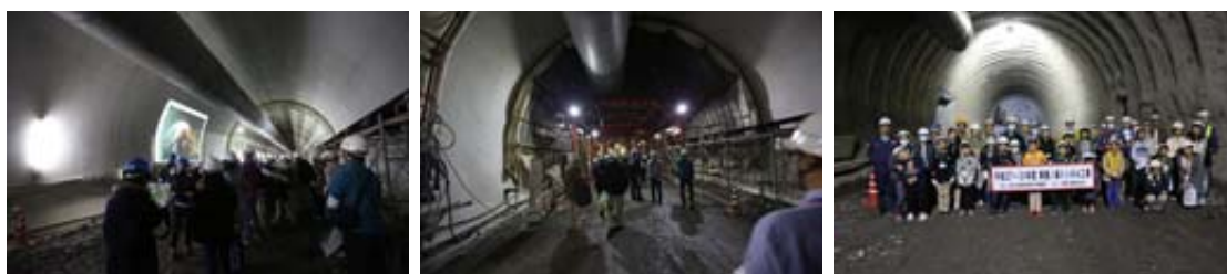
新猪ノ鼻トンネル内での説明、先端切羽目指して前進、到着した切羽前で記念撮影
