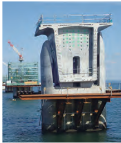
四国横断自動車道路 吉野川大橋の建設現場
