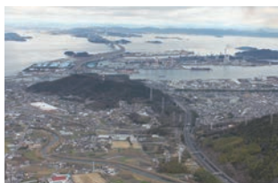
本州四国連絡橋見島・坂出ルート全景
