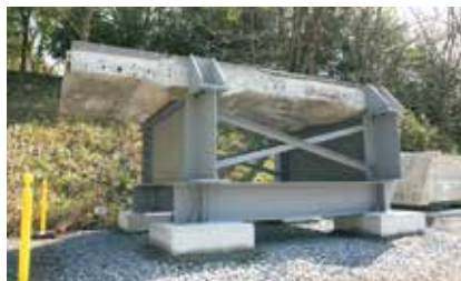
鉄筋コンクリート床版
