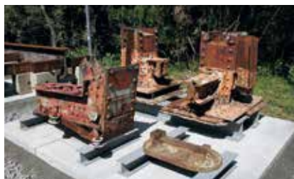
鋼トラス橋・支承
