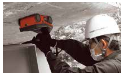
電磁波レーダーによる非破壊検査
