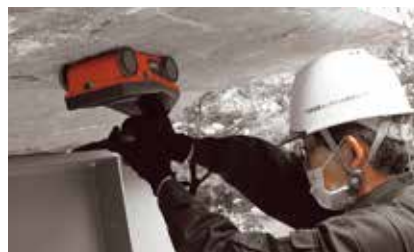
電磁波レーダーによる非破壊検査
