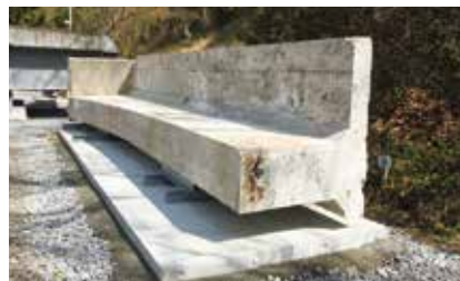
鉄筋コンクリート桁
