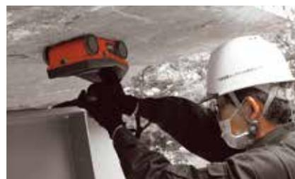
電磁波レーダーによる非破壊検査
