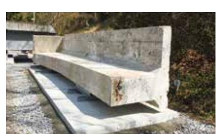
鉄筋コンクリート桁
