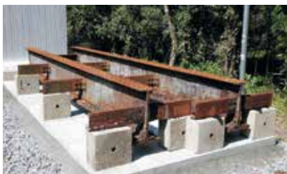
鋼リベット桁
