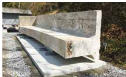
鉄筋コンクリート桁
