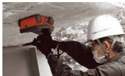
電磁波レーダーによる非破壊検査
