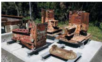
鋼トラス橋・支承
